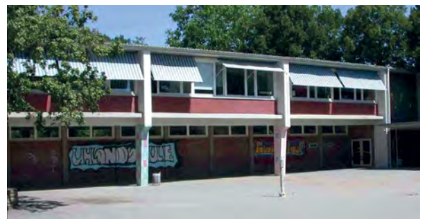
In vielen Kommunen stehen Sanierungen von Bildungsbauten an. Die Uhlandschule in Stuttgart wird zu einer Plusenergieschule umgebaut.
