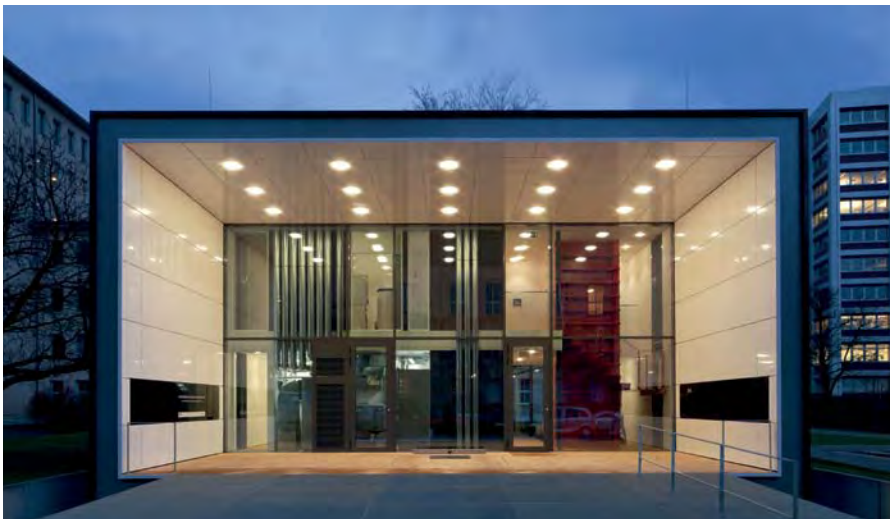
Leuchtturmprojekt Effizienzhaus Plus mit Elektromobilität in Berlin im Jahr 2011
